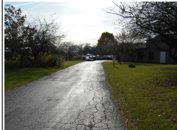
8 EXISTING ACCESS DRIVE SCALE: N.T.S.
