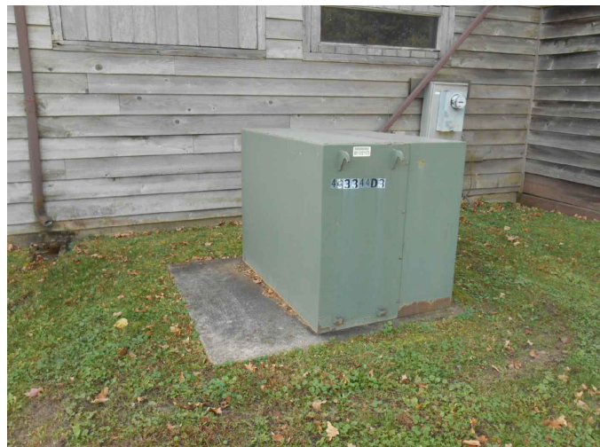
5 EXISTING TRANSFORMER SCALE: N.T.S.
