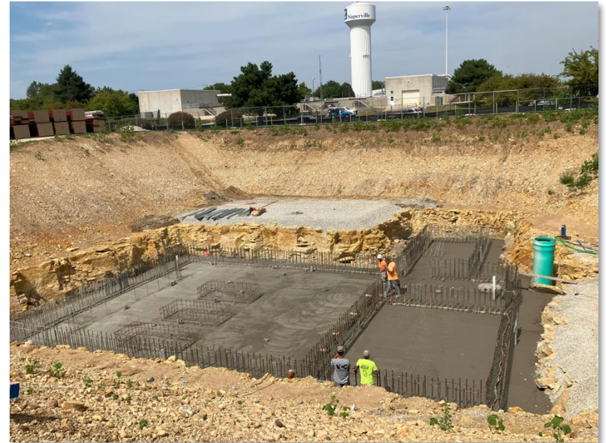
South Plant grit/RAS base slab pour
